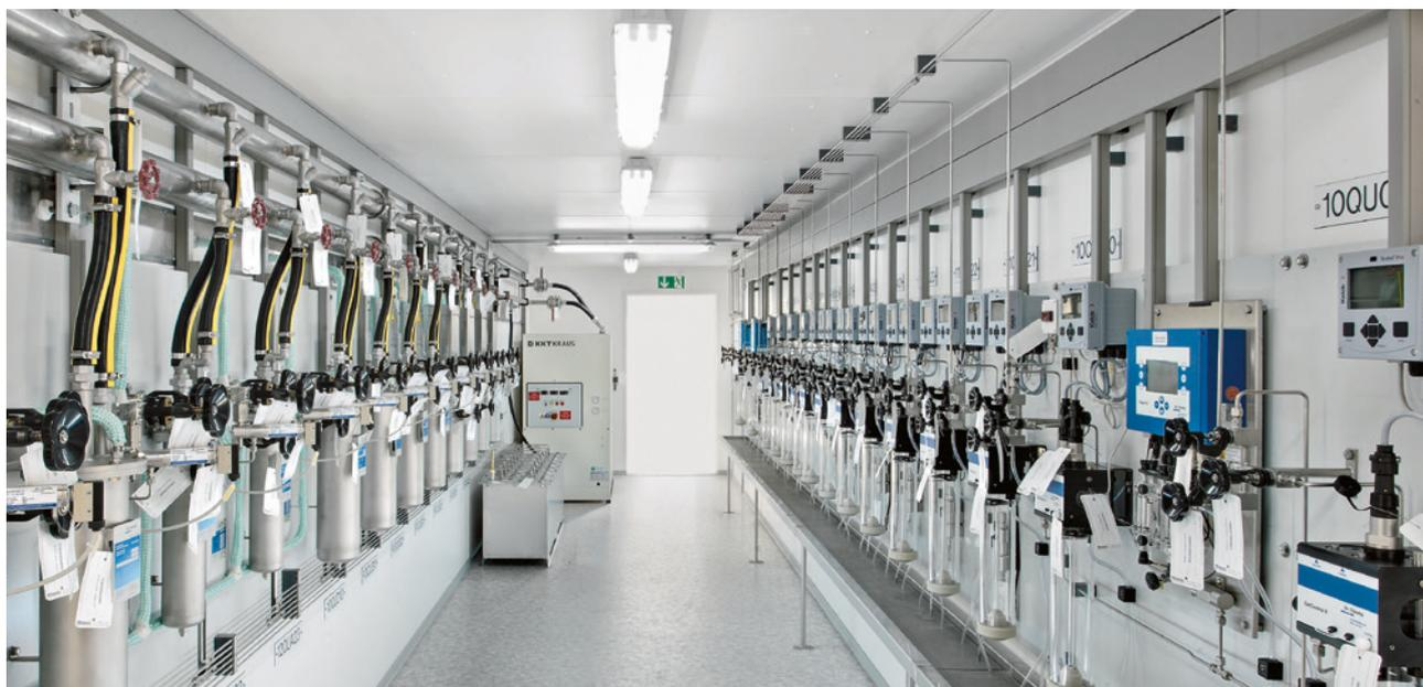
In größeren Kraftwerken werden für gewöhnlich alle Qualitätsmessungen in Verbindung mit Kessel, Kesselspeisewasser und Dampfkondensat zentral in großen Analysencontainern überwacht (Quelle: Dr. Thiedig GmbH & Co KG, Berlin).
